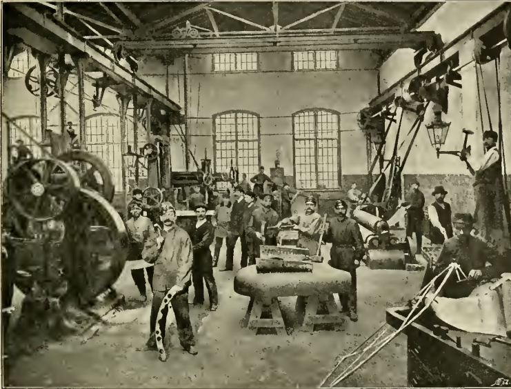
Abb. 380. Werkstätte Neu-Sandec der k. k. Oesterreichischen Staatsbahnen. [Blechbearbeitungs-Werkstätte.]
